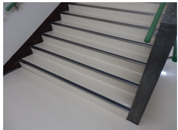
1-9 階段が滑りやすく、事故につながるのと来校者の指摘により滑り止めをつけました。
