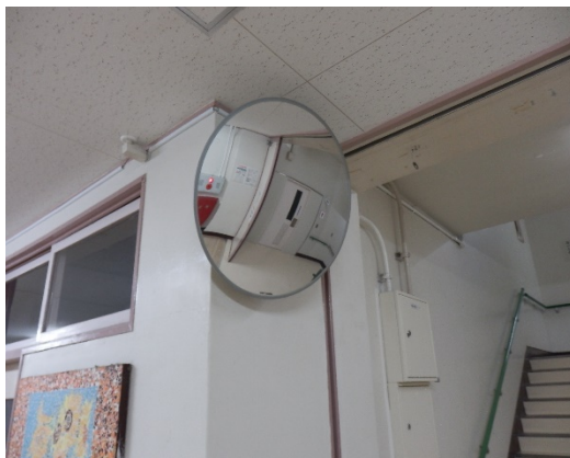
1-8 階段と廊下での出会い頭での衝突事故を契機にミラーを設置しました。
